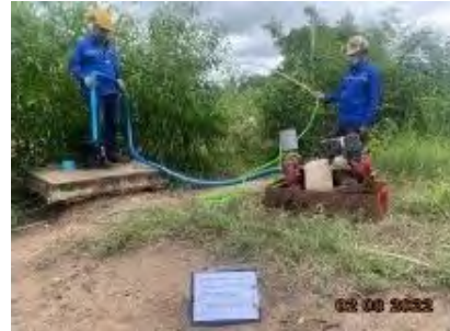
สูบน้ำออกจากบ่อ
